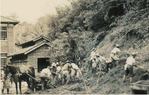
判田小学校の裏山土砂崩れ（昭和30年）
