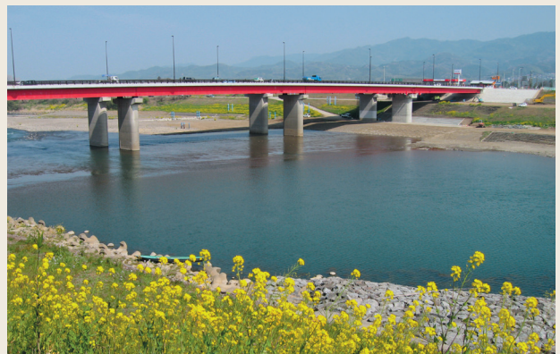
上りは、昭和56年に施工、平成18年に補修。 下りは、平成17年に竣工。（平成19年3月）
