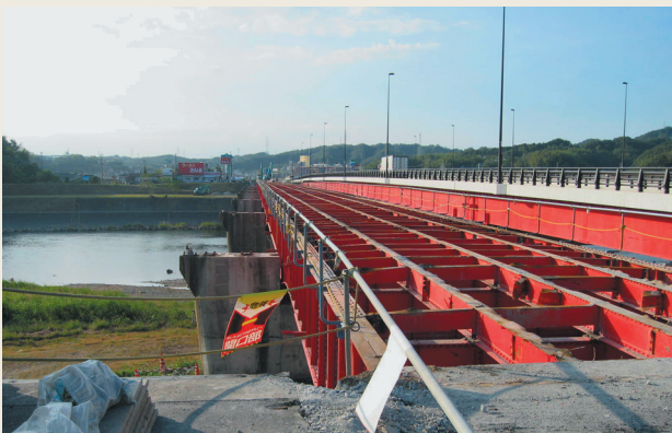
上の橋も、下りの橋が出来たため平成18年に取り壊す。
