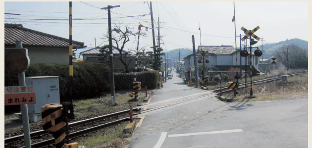
現在の昆布刈踏切付近 (平成26年2月) 遮断機の自動化で踏切小屋は廃止
