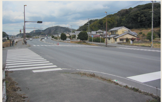
国道10号線拡幅後（上戸次上り尾）
