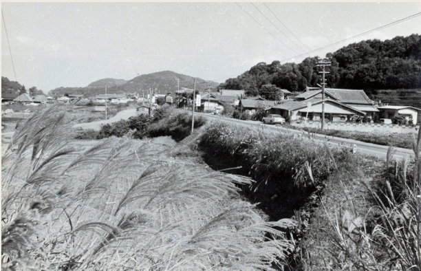
国道10号線拡幅前（上戸次上り尾）
