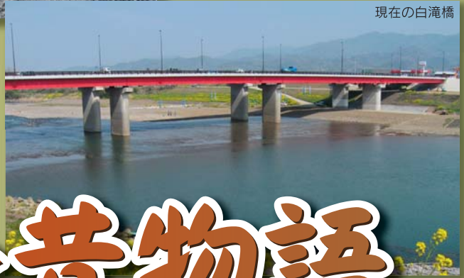
現在の白滝橋
