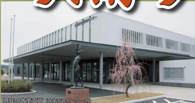
現在の大南支所（大南市民センター内）
