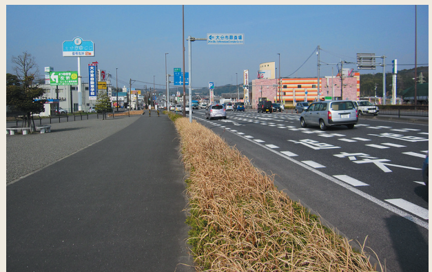
国道10号線白滝橋付近から撮影 （平成26年2月 判田側）
