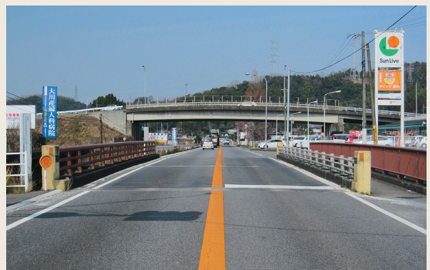
国道10号線昆布刈橋付近から撮影 （平成26年2月）
